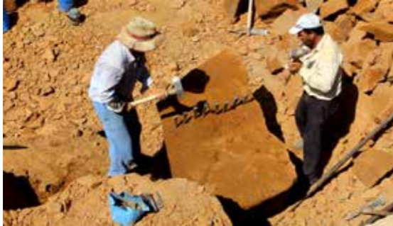
Görsel 17. Çıkarılan Taşın Daha Küçük Parçaya Ayrılması
